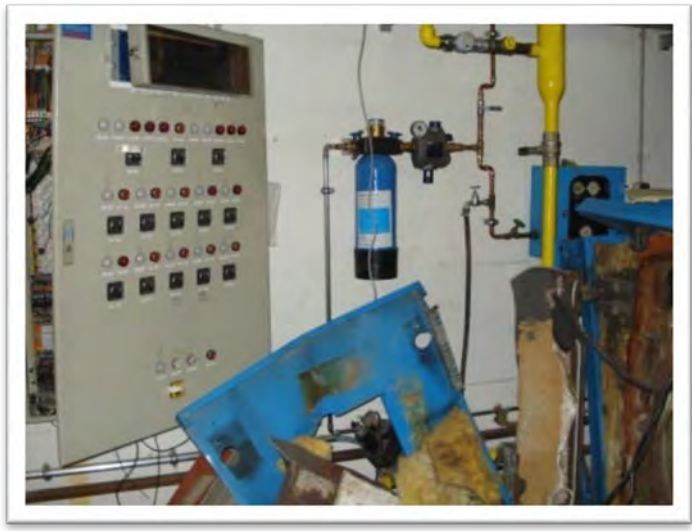
Abbildungen 1 und 2: Die völlig zerstörte Heizungsanlage
