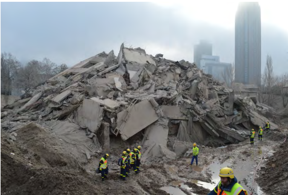
Abbildung 3: Das Sprengergebnis – ein riesiger Schutthaufen
