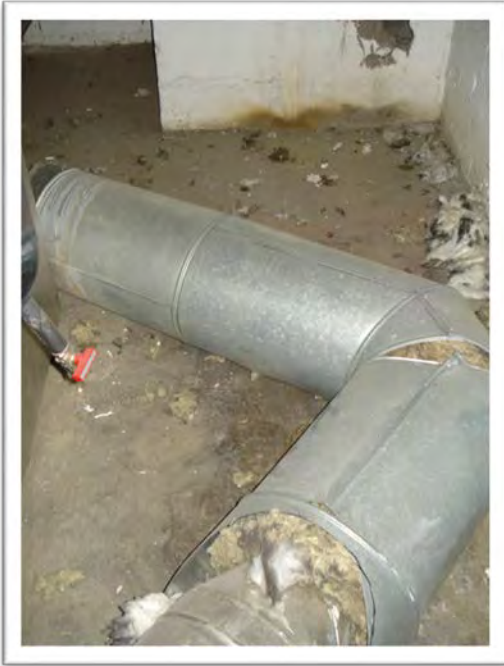
Abbildung 3: Abgerissene Abgasleitung
