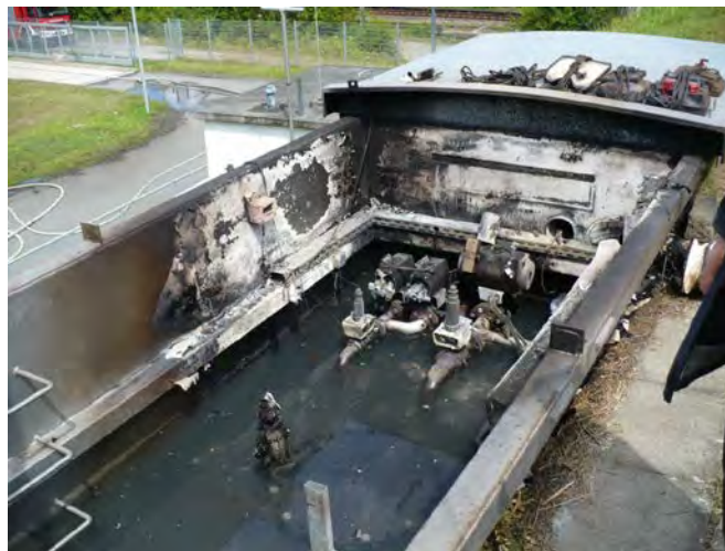
Abbildung 1: Gefluteter Domschacht des Propan-gastanks
