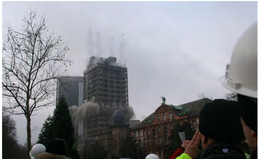
Abbildung 2: Sprengung Wasserbehälter und Skelettbau (1. Sprengung)
