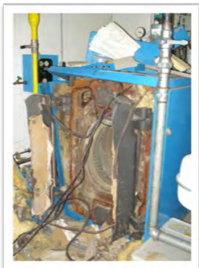
Abbildungen 1 und 2: Die völlig zerstörte Heizungsanlage
