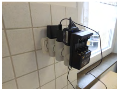
Abbildung 2: Verschiedene Adapter werden ineinandergesteckt und führen zur sogenannten „Christbaumbildung“
