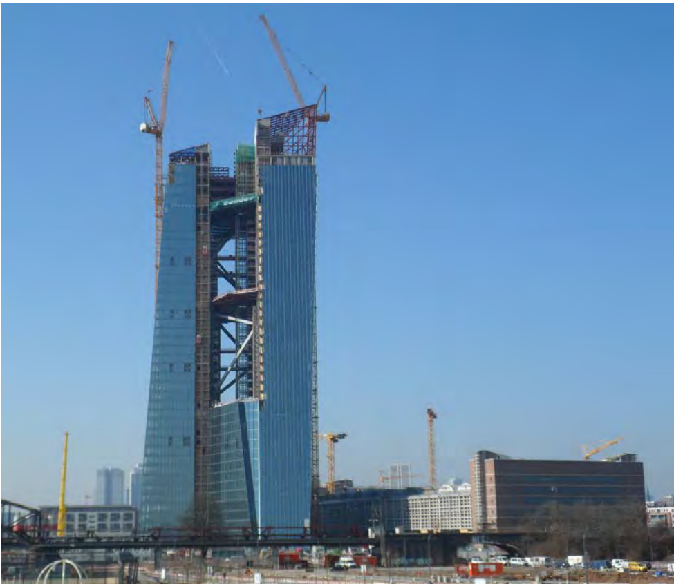
Abbildung 1: Links Neubau EZB-Hochhaus (Gesamthöhe ca. 210 Meter), Nord- und Süd-turm mit Stahlkonstruktion als aussteifende Verbindung und rechts Kopfbau Ost mit
