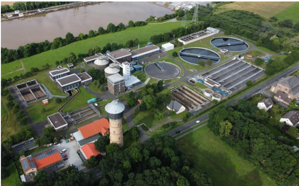
Abbildung 1: Beispielbild – Luftbildaufnahme der Gruppenkläranlage Hanau in Maintal (Quelle: Magistrat der Stadt Hanau).
