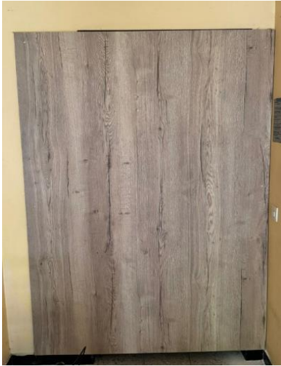
Abbildung 3: Die erfolgte Umsetzung der Absicherung durch einen Fachbetrieb.
