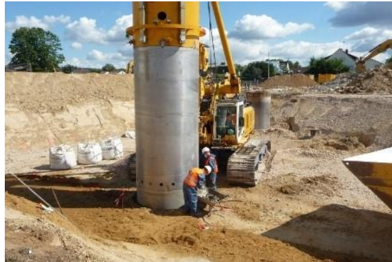
Abb. 2b: Tiefbau (Quarzstaubexposition)
