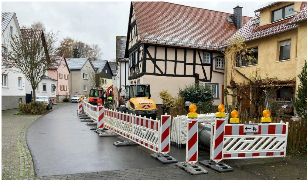
Abbildung 1: Vollflächig abgesicherte Straßenbaustelle (Foto: F. Cyriax, RPGI).
