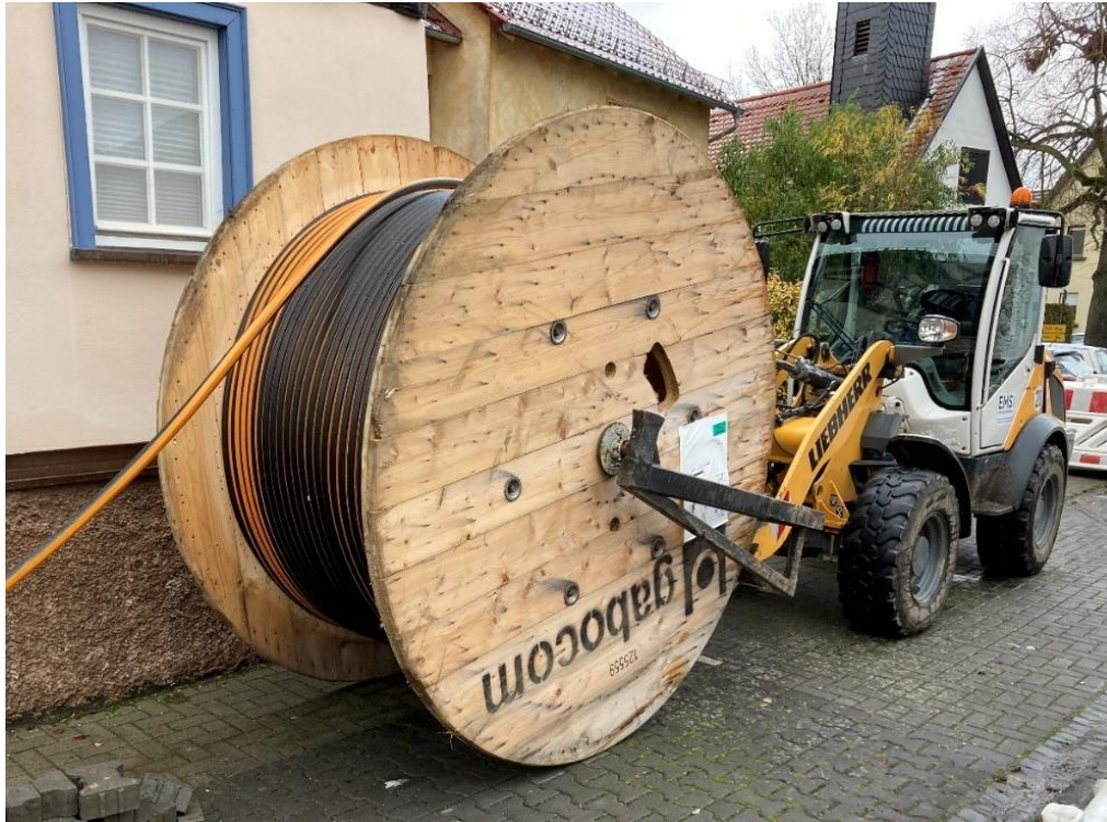
Abbildung 2: Anbaugerät am Radlader zum Verlegen von Leerrohren (Foto: F. Cyriax, RPGI).
