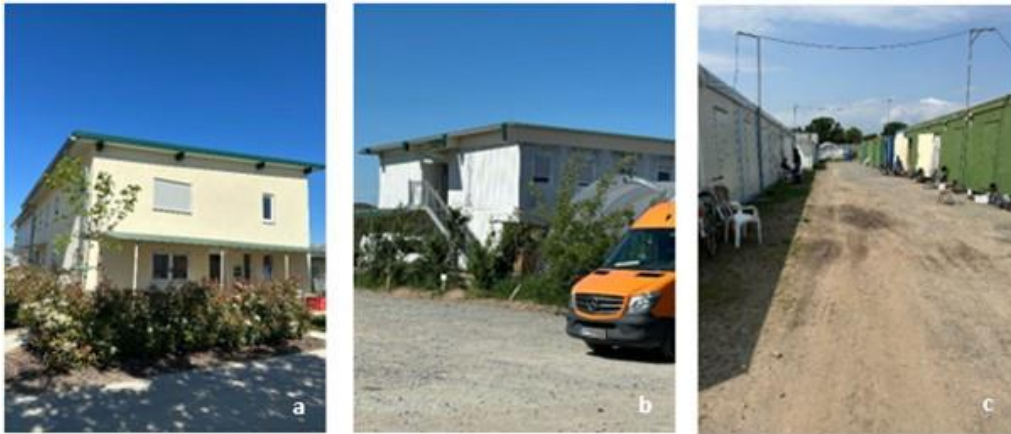
Abbildung 1 a bis c: Beispielhafte Bilder von Unterkünften – Gebäude und Containerbauweise.
