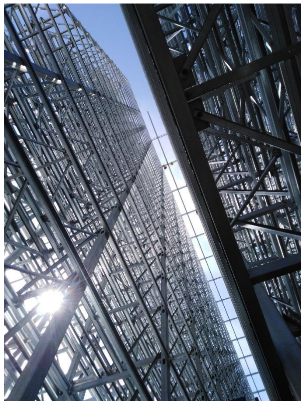
Abbildung 1: Obere Führungsschiene in einem Regalgang
