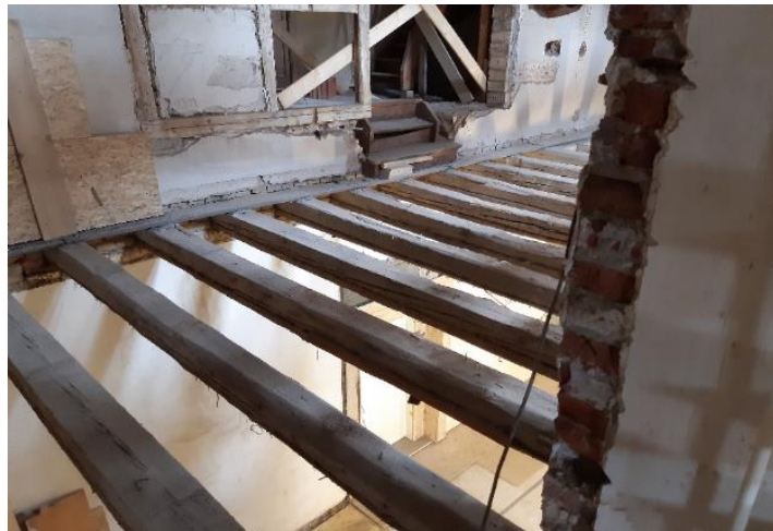
Abbildung 1: Freiliegende Balken, die zum Unfall führten
