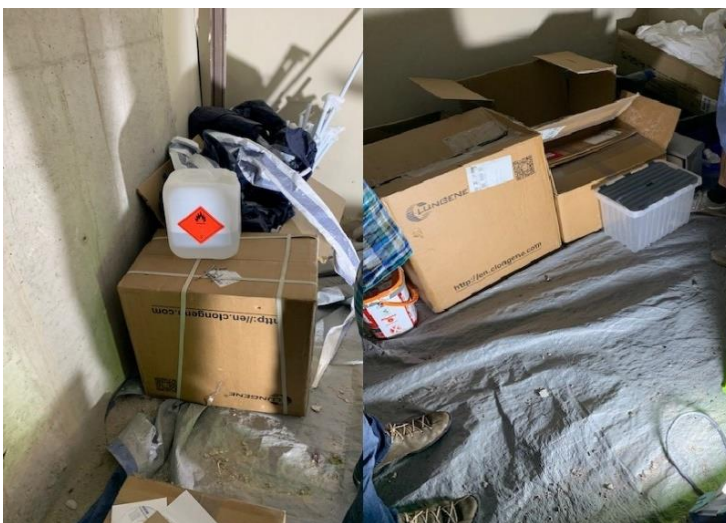
Abbildung 6: Unzulässige Lagerung von Tests im Baustellenbereich
