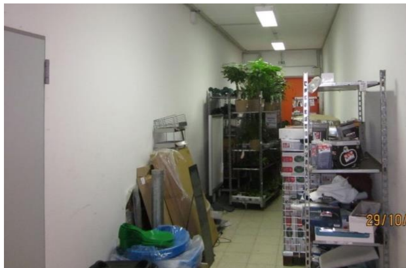
Abbildung 2: Ein komplett zugestellter Fluchtweg
