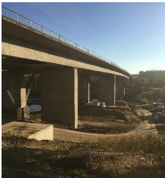
Abbildung 1: Die Salzbachtalbrücke – das Baufeld aus Richtung Westen gesehen
