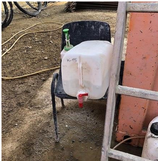
Abbildung 2: Typisches Bild auf Baustellen, wenn kein fließendes Wasser zur Verfügung steht: Wasserkanister mit Auslasshahn (zulässig, wenn auch Flüssigseife sowie Einmalhandtücher gestellt werden)
