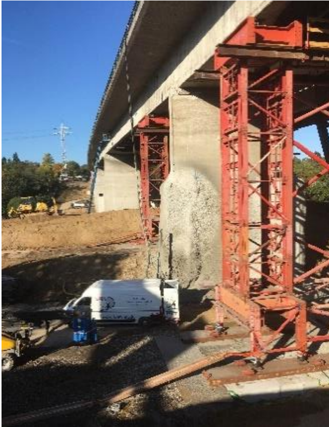
Abbildung 3: Stahlstützen neben dem beschädigten Pfeiler
