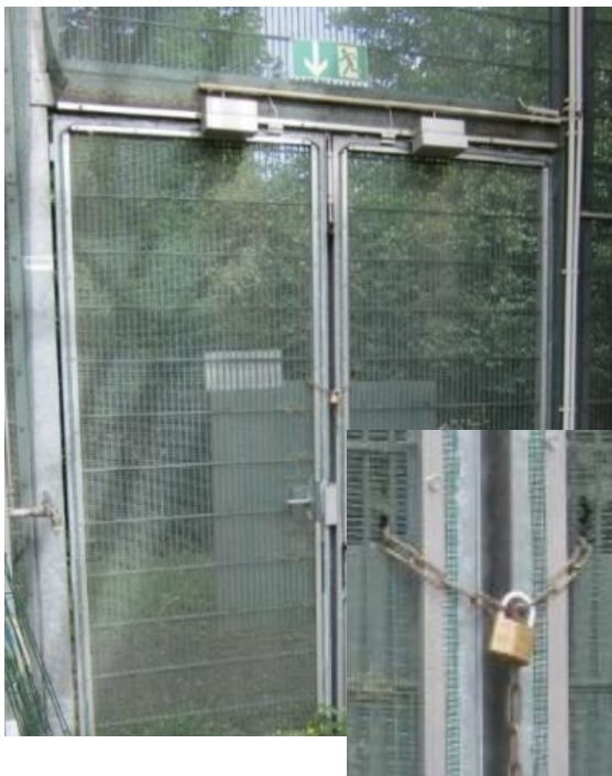
Abbildung 1: Mit Kette und Schloss verschlossener Notausgang
