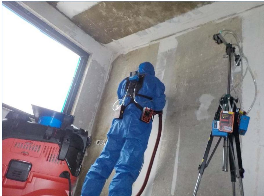
**Abbildung 1: Messungen beim Schleifen von gespachtelten Betonwänden in einem Sanierungsobjekt in Münster**
