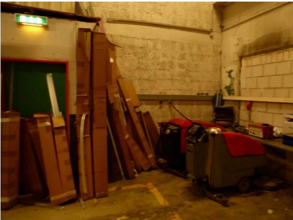
**Abbildung 1: Batterieladestationen mit brennbaren Kartonagen im Schutzbereich**
