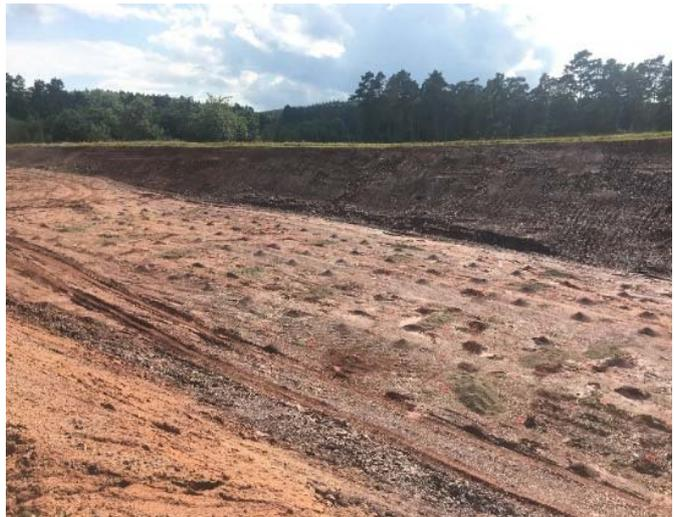
Die erste von mehreren Sprengungen im Verlauf der nächsten Wochen erfolgte am 20. Juli 2017. Für die Sprengung wurden etwa drei Tonnen Sprengstoff auf insgesamt 120 Bohrlöcher verteilt. Dabei kann mit der Anordnung der Bohrlöcher, der Zünder und der Sprengstoffauswahl auf Streuflug und Erschütterungen Einfluss genommen werden.
