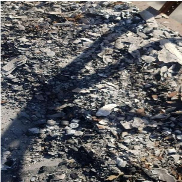
**Abbildung 1: Über den gesamten Innenhof verteilte Bruchteile der Dachhaut**
