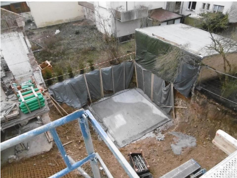
**Abbildung 1: Blick in die mangelhaft gesicherte Baugrube (Foto: G. Lohse)**
